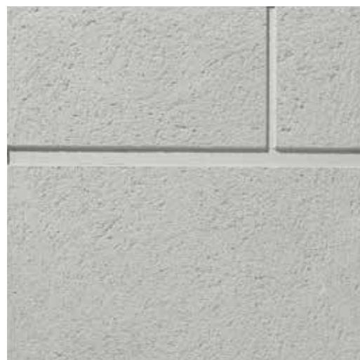
掻き落とし石積(押し目地) 塗込厚:10~15mm
