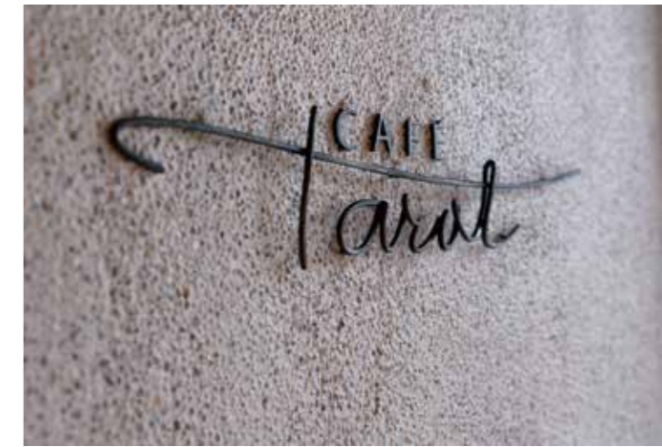
カフェタロー 設計：株式会社ルビオ岩崎デザイン事務所 壁：ユニプラルSL #276+ #400 洗出し photo：馬場道浩
